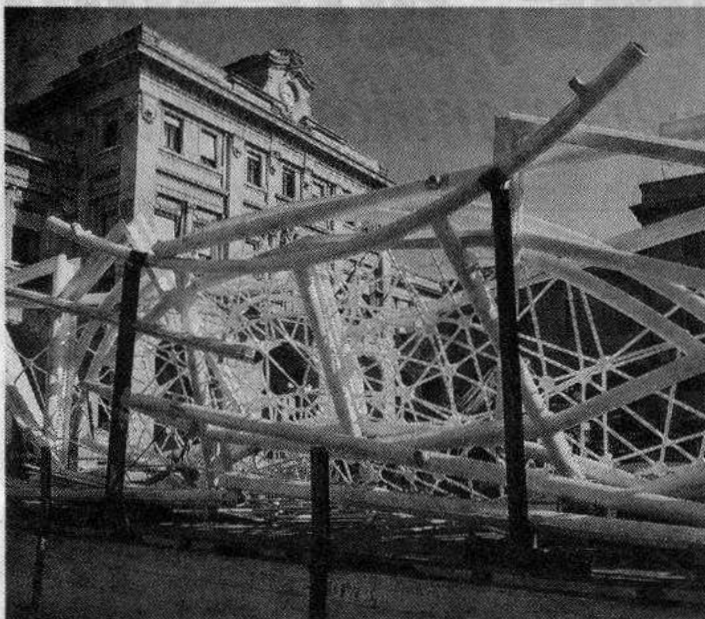
La struttura metallica in piazza Indipendenza (Foto Gavagnin)
