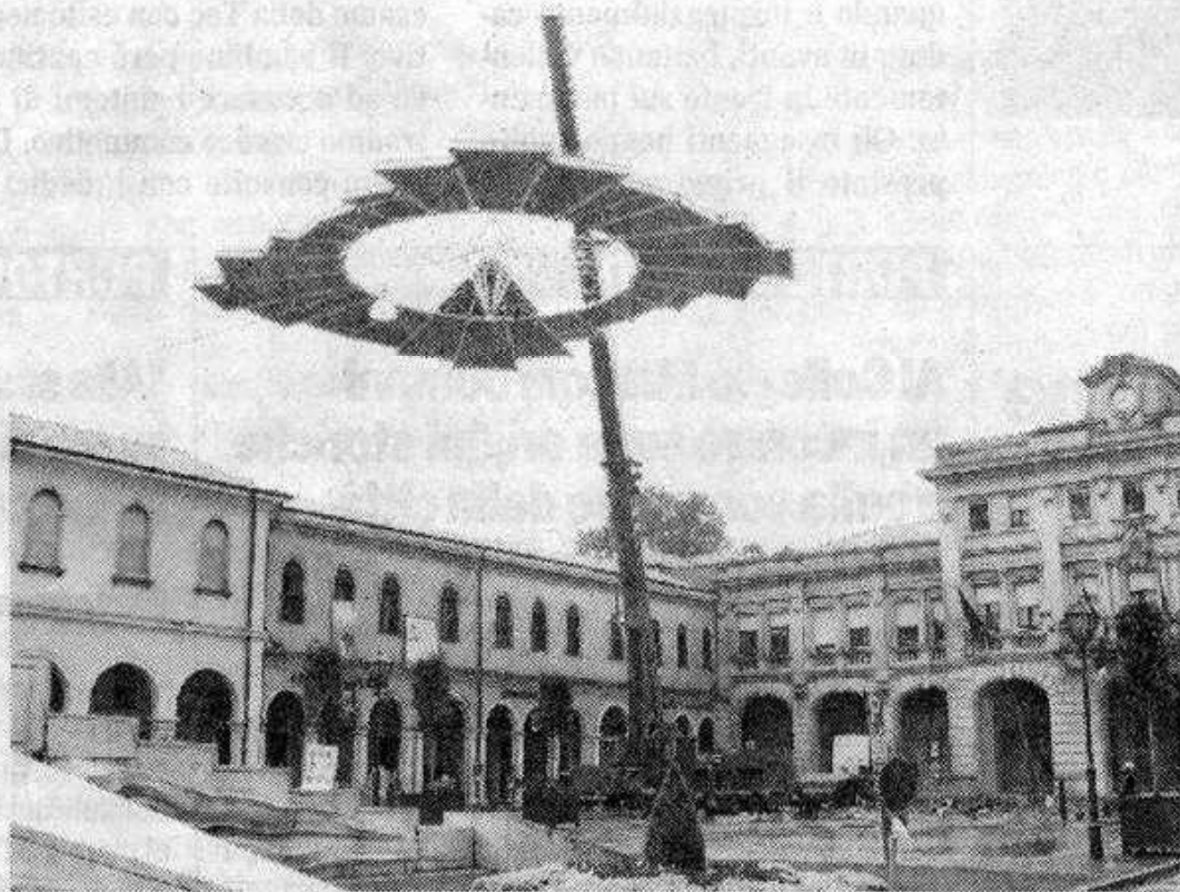
Le fase conclusive della collocazione della cupola per il caffè letterario
