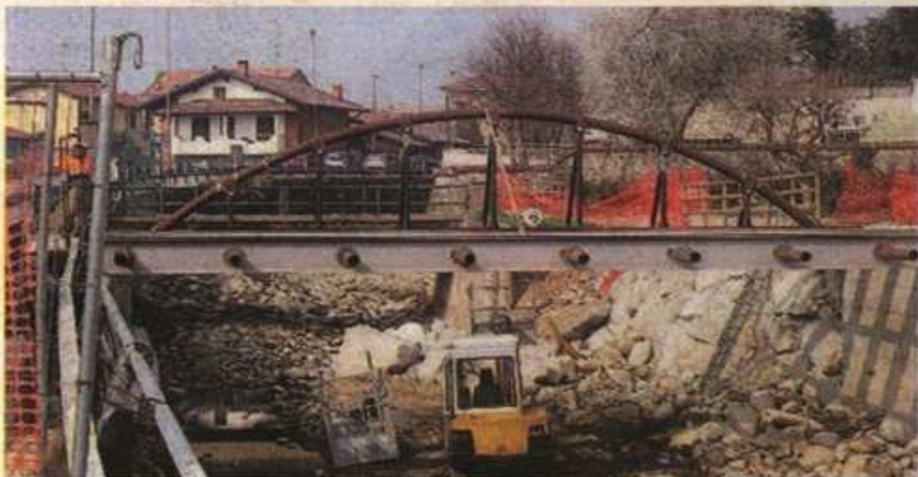
Una veduta del nuovo ponte che sta prendendo forma
